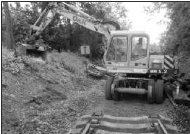
Část lokální trati Zadní Třeň - Lochovice byla v polovině června rekonstruována. „Pět set metrů starých dřevěných pražců jsme vyměnili za betonové. Zkvalitní se tak i jízda pro cestující,“ sdělil Svetoslav Gamrat z firmy, která koleje ve Třebani opravovala. Lokální trať tak byla od 10. června do 19. uzavřena, mezi Zadní Třebaní a Litní jezdil místo lokálky autobus. (pef)
